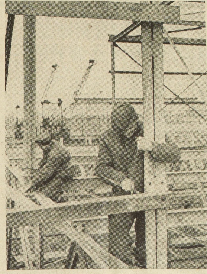
Budowa kombinatu Nowej Huty. Robotnicy przy montażu obiektu
