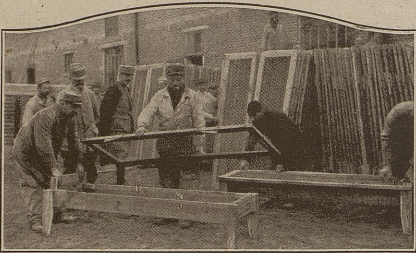
CONFECTION DE CHALITS EN TREILLAGE POUR LE COUCHAGE DANS LES ABRIS
