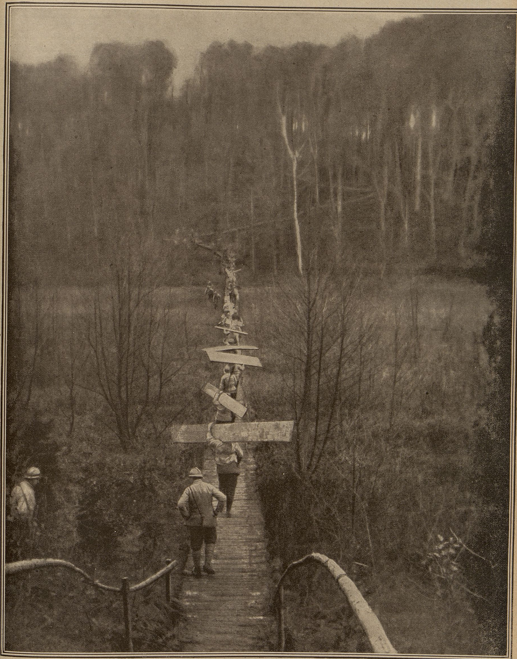
Ce sentier, déjà détrempé par les pluies, était devenu un véritable cloaque par suite de l'incessant va-et-vient de nos poilus ; des rondins accolés en ont fait une piste praticable qui se prolonge sur plusieurs kilomètres ; sans crainte de s'enliser dans la boue, les soldats la parcourent allègrement, portant les matériaux nécessaires à la construction des abris.
