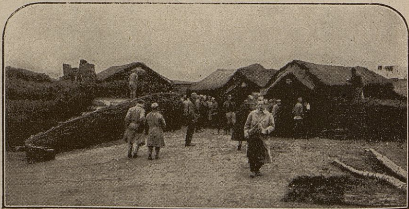
CANTONNEMENT CONSTRUIT EN TERRE ET REVÊTU DE GENÊTS
