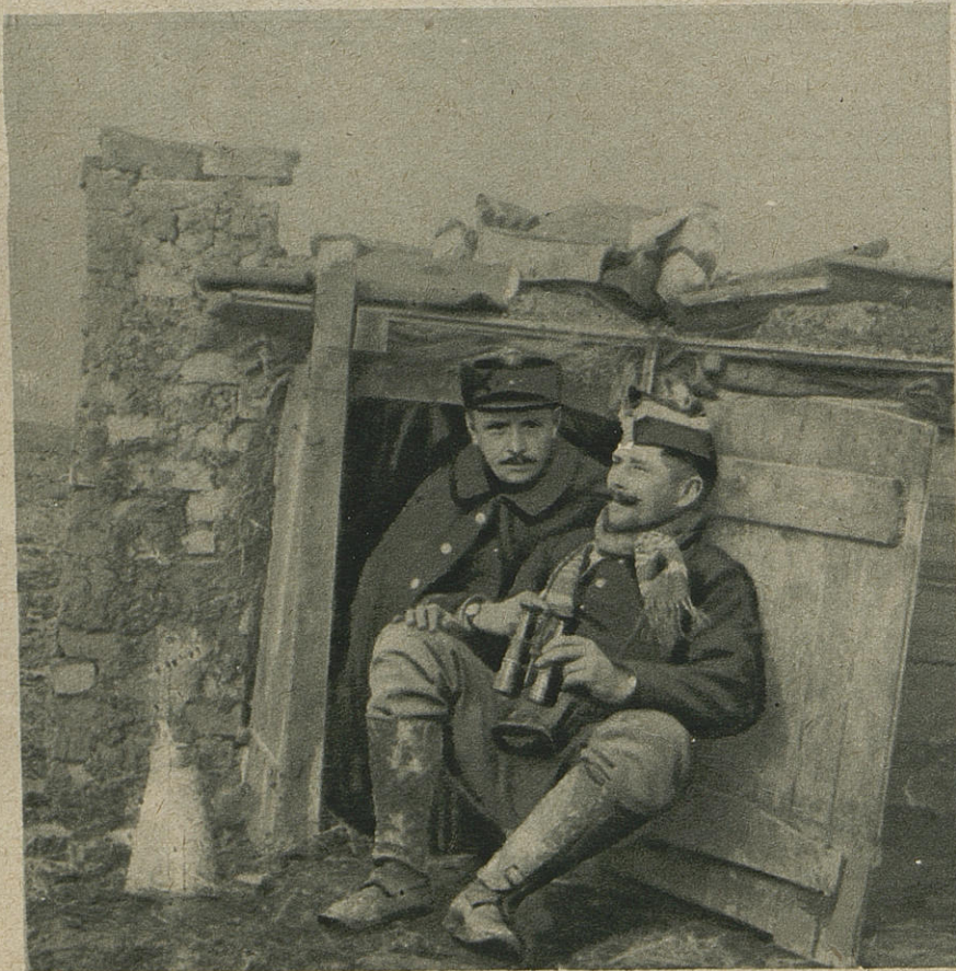
L'ENTRÉE D'UNE TRANCHÉE BELGE
