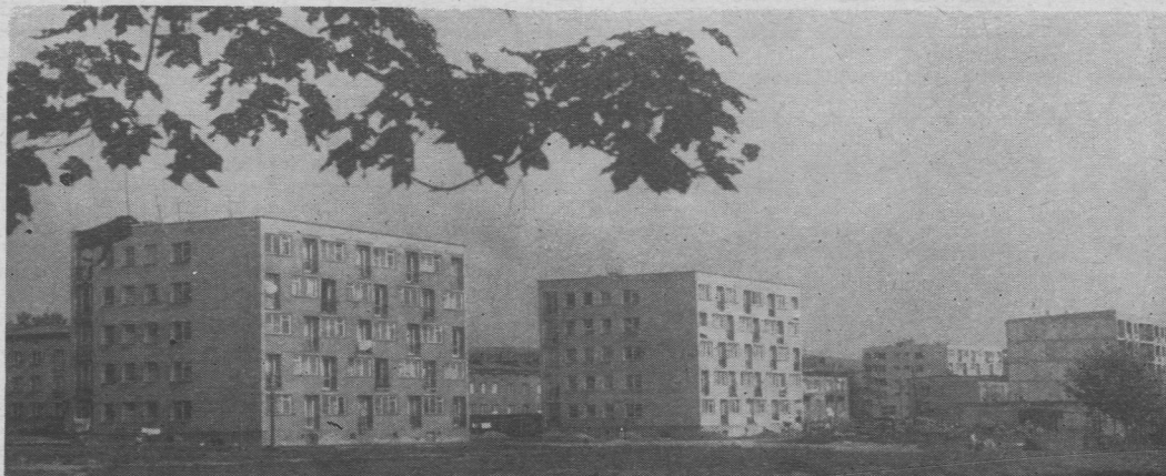
W nowym osiedlu gaz do gotowania i ogrzewania, na domach nie ma kominów
