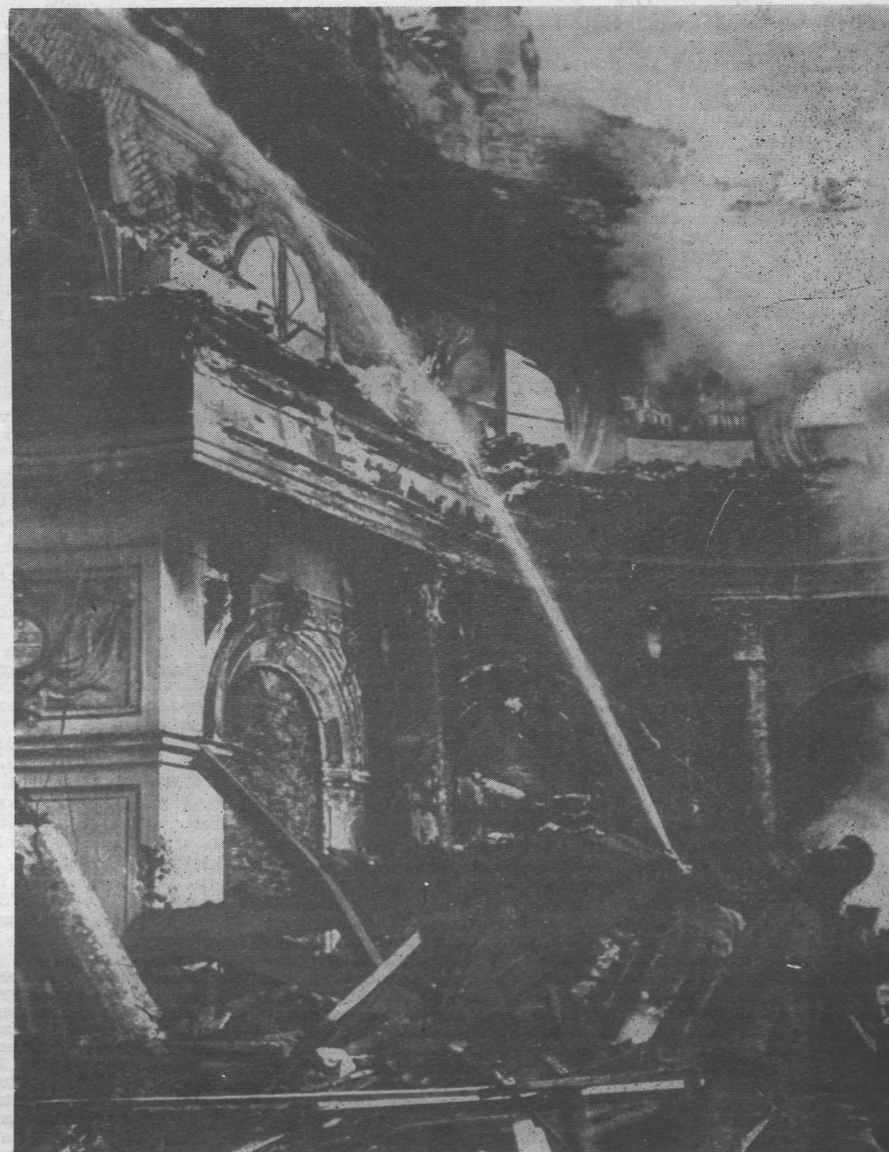
Gaszenie pożaru sali balowej Zamku Królewskiego we wrześniu 1939 roku
