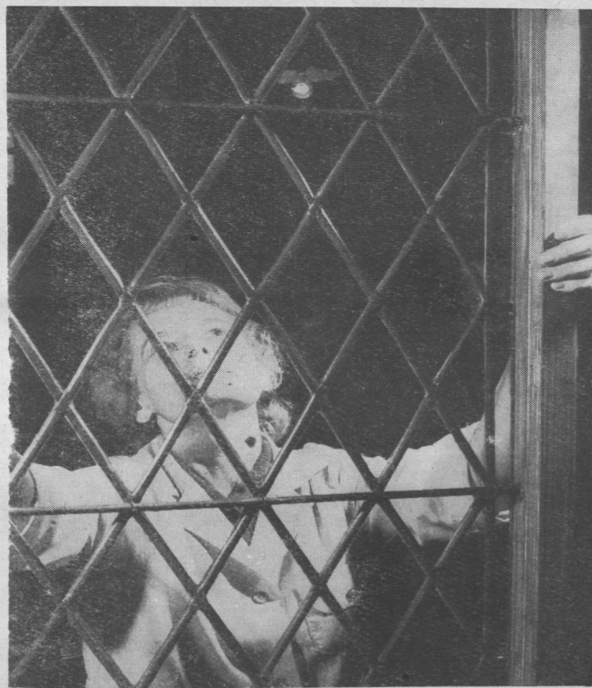
Rama powstaje z rurek, które wspierają taśmy z ołowiu. Witraż musi koniecznie zachować starą technikę
