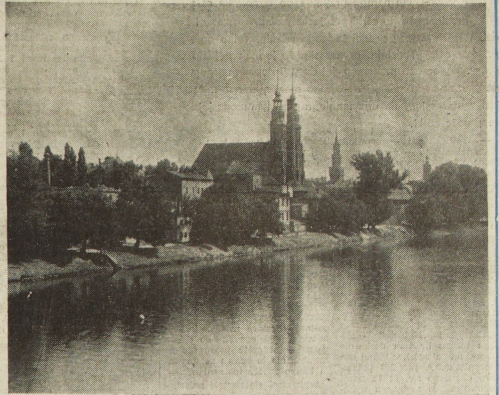
OPOLE. — Widok ogólny od strony Odry.
