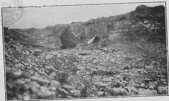
Ouvrage de La Lautée.
