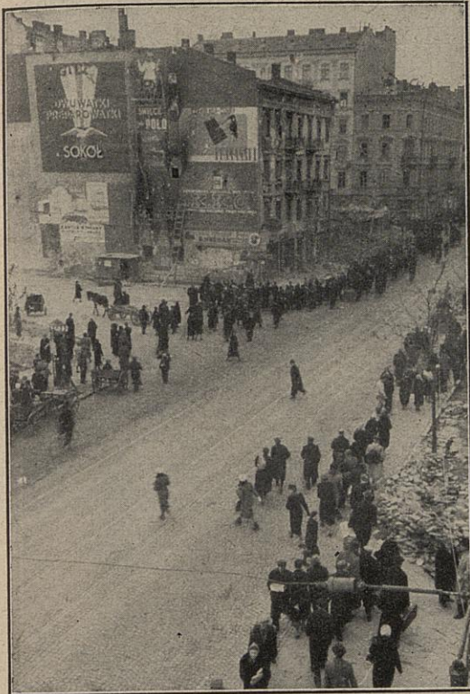
Häusermauern mit langen Rissen stehen an einer der Straßen Warschaus. Unter ihnen flutet lebhafter Verkehr, Passanten sind von früh bis abends unterwegs. Jederzeit droht die Gefahr eines Einsturzes.
