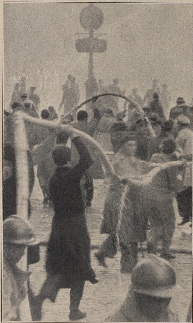
Schläuche waren undicht!
