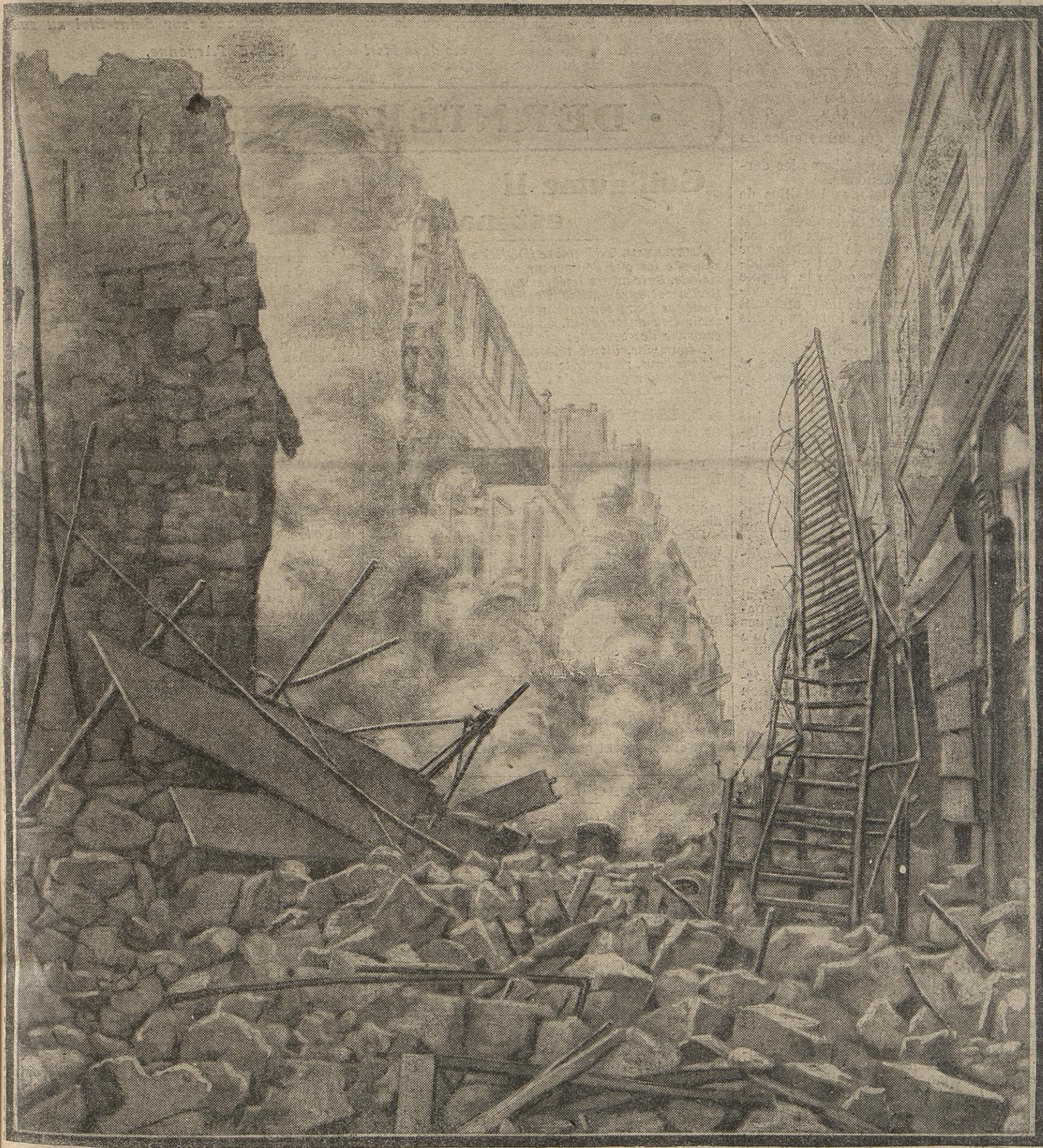
Récemment encore, Soissons fut bombardée par l'ennemi. Seules, quelques maisons d'ailleurs furent endommagées par les obus allemands. Cette photographie a été prise quelques instants après l'explosion d'un projectile tombé dans un quartier de la ville au moment où l'incendie finissait de consumer les dernières habitations.
