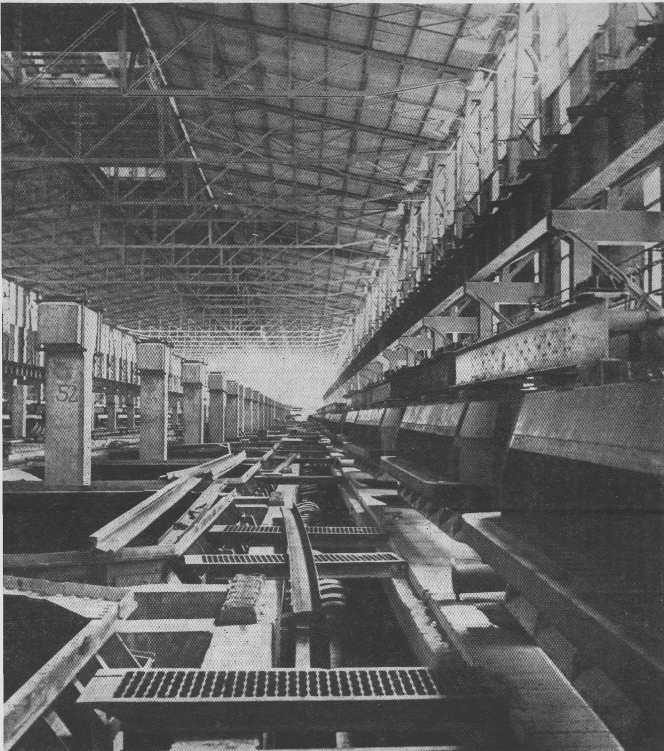
Setki metrów hal, tysiące ton betonu, gmatwanina urządzeń, które za rok zdadzą egzamin swej przydatności
