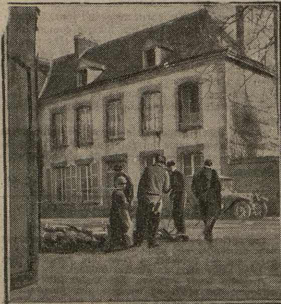
Travail pour l'écoulement des eaux sales sur le front
