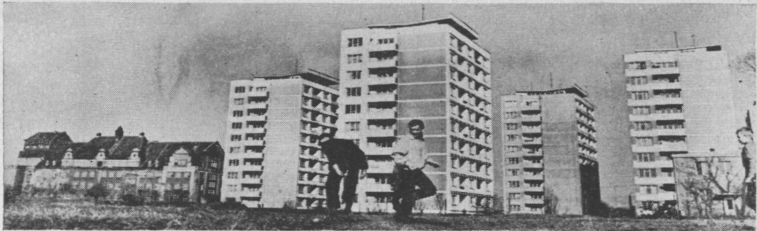
Dwie epoki — dwa style: ciężkie budowle mieszczańskiego XIX stulecia i jasne, radosne budynki, dzieło współczesnych architektów nowego Gdańska na osiedlu im. „Poczty Gdańskiej”
