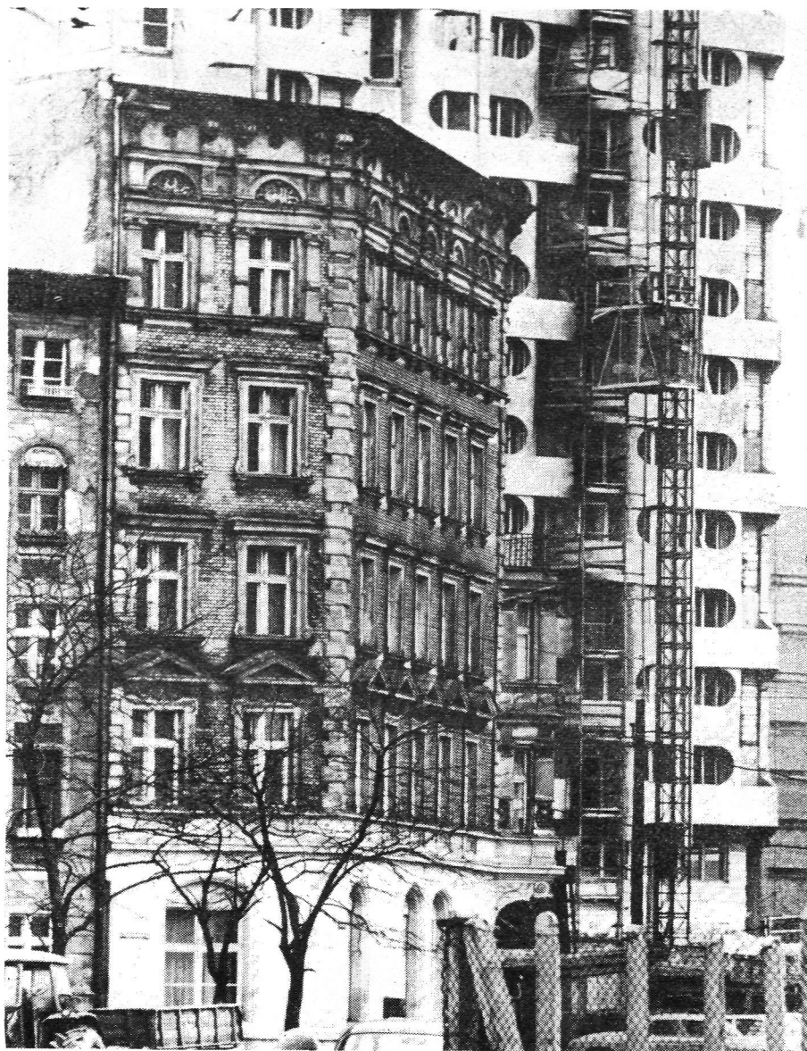
Prefabrykowane domy powstają tuż obok starych przedwojennych kamienic
