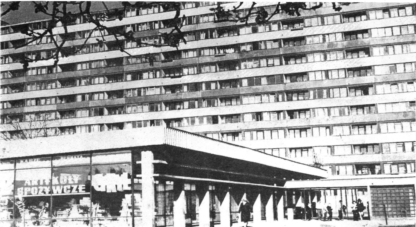
Oto jeden z nowoczesnych domów mieszkalnych we wrocławskiej dzielnicy Krzyki. Zbudowany jest z wielkich płyt
