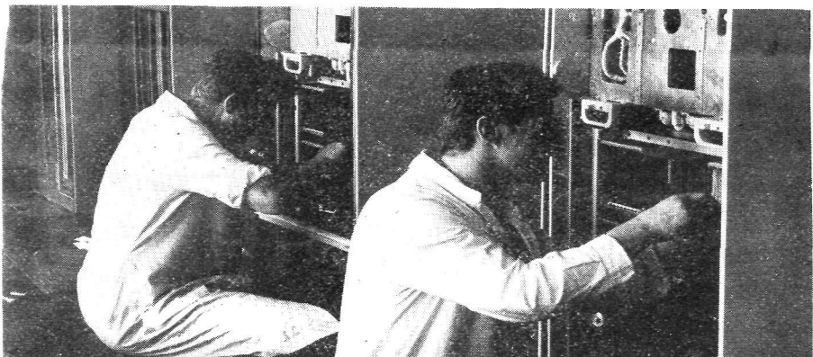
Montaż elementów wewnątrz szafy z pamięcią taśmową
