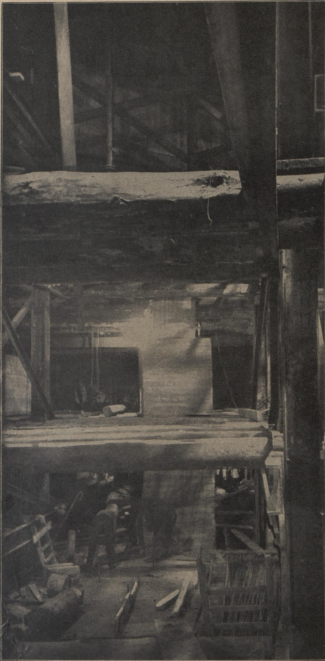
Hier entsteht der größte unterirdische Bahnhof der Welt! Hoch oben der brausende Verkehr des Potsdamer Platzes — ein Stockwerk tiefer die alte U-Bahn, die ohne Verkehrsunterbrechung in einer Länge von dreißig Meter abgefangen und auf eine unterirdische Brücke gestellt wurde (hinter dem Holzzaun oben links im Bilde fährt sie vorbei) — ganz unten aber wachsen beim Dröhnen der Hämmer und beim Rattern der Preßluftbohrer die ersten steinernen Säulen des neuen gewaltigen Bahnhofs empor. Hanns Hubmann (3)
