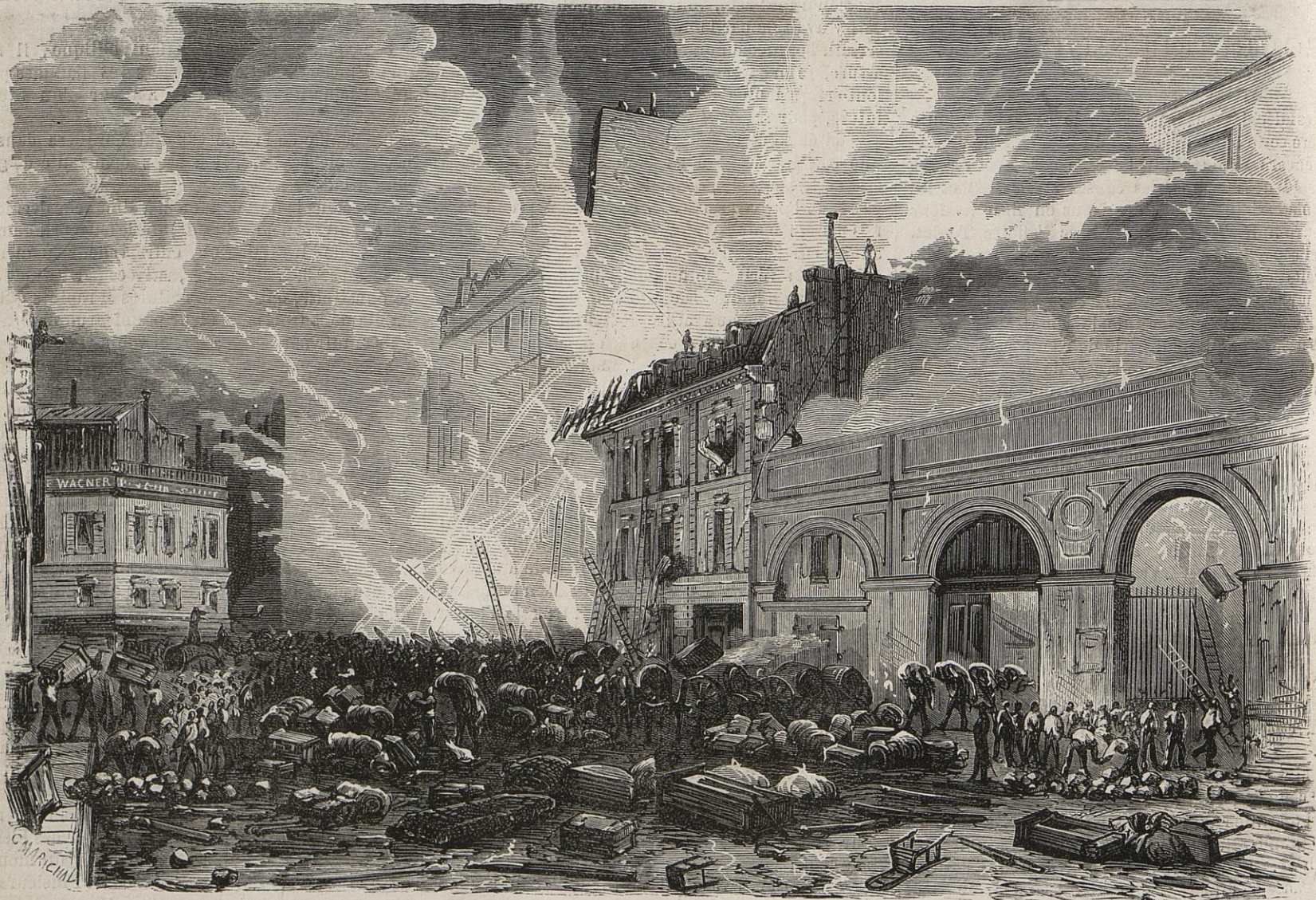
PARIS. — Incendie des ateliers de menuiserie de la rue Chaptal.
