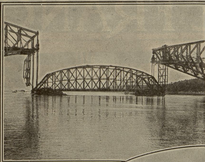
Ici, l'arche portée sur des pontons arrive à l'aplomb des deux arches fixes, entre lesquelles elle sera placée pour compléter le pont.
