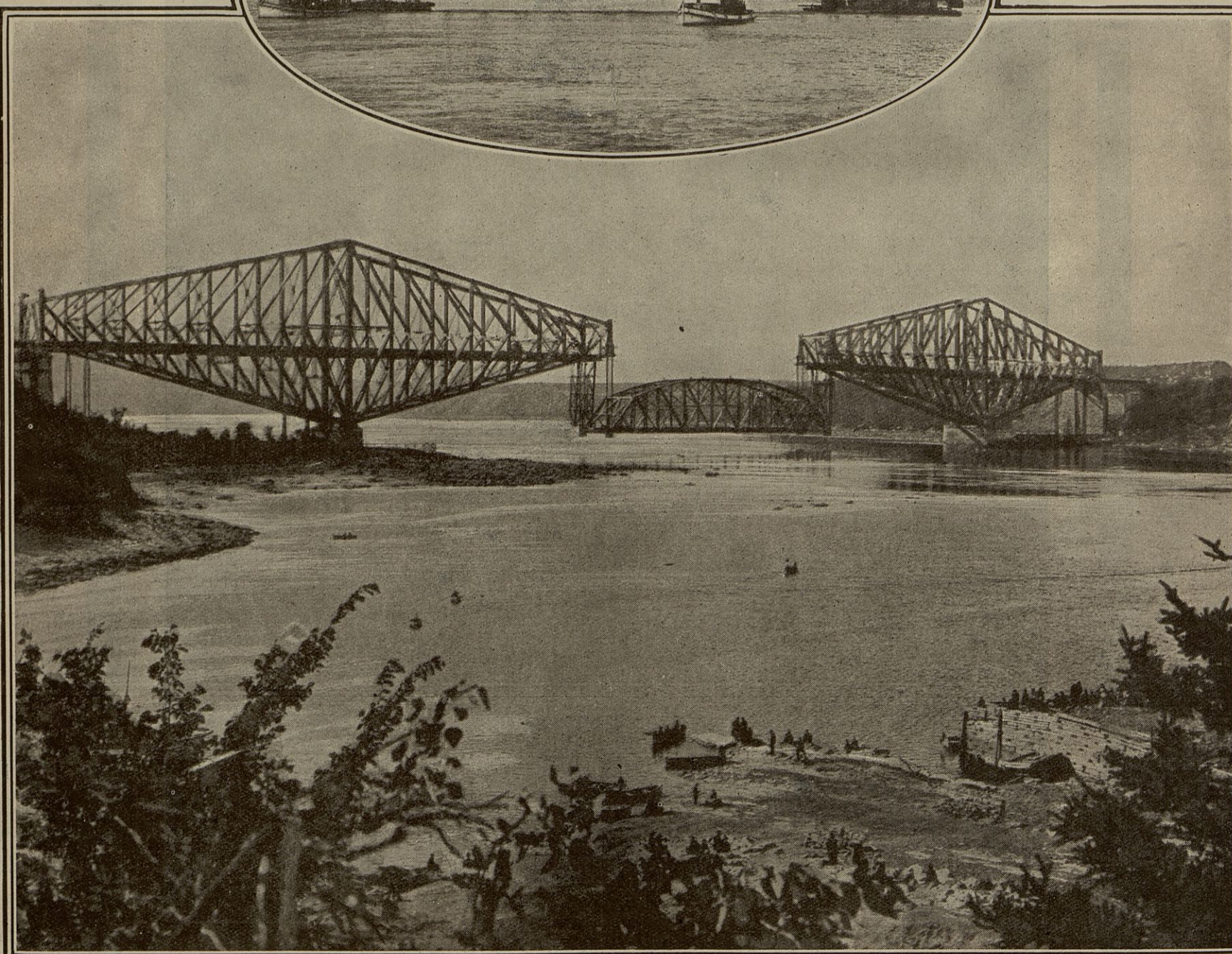
Ici, l'arche portée sur des pontons arrive à l'aplomb des deux arches fixes, entre lesquelles elle sera placée pour compléter le pont.
