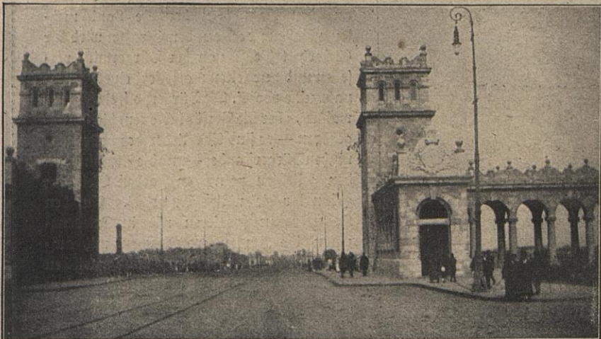
Die große Weichselbrücke in Warschau, deren Bau sieben Millionen Mark gekostet hat.
