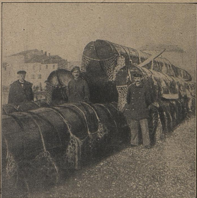
Von den österreichisch-ungarischen Matrosen aus dem Hafen von Grado gezogene Holzbalken, an denen große Stahlbrahtsege befestigt waren, die die Italiener zum Schutz gegen U-Boot-Angriffe verwendeten.
