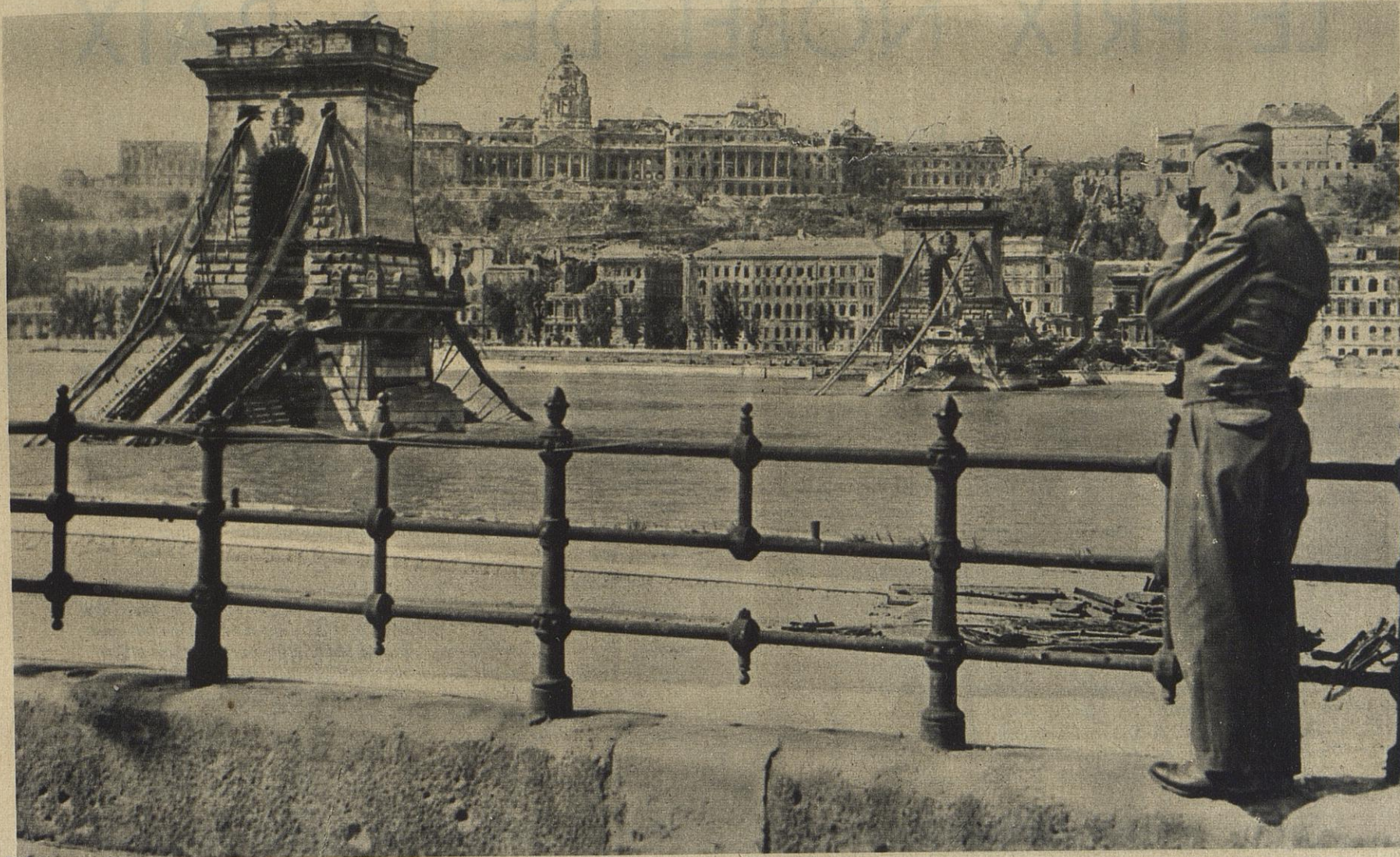
L'effondrement du pont de la Chaîne, à Budapest, marque la fin d'un monde : celui des hobereaux hongrois. Cette vue tragique va entrer dans un album de famille du Middlewest.
