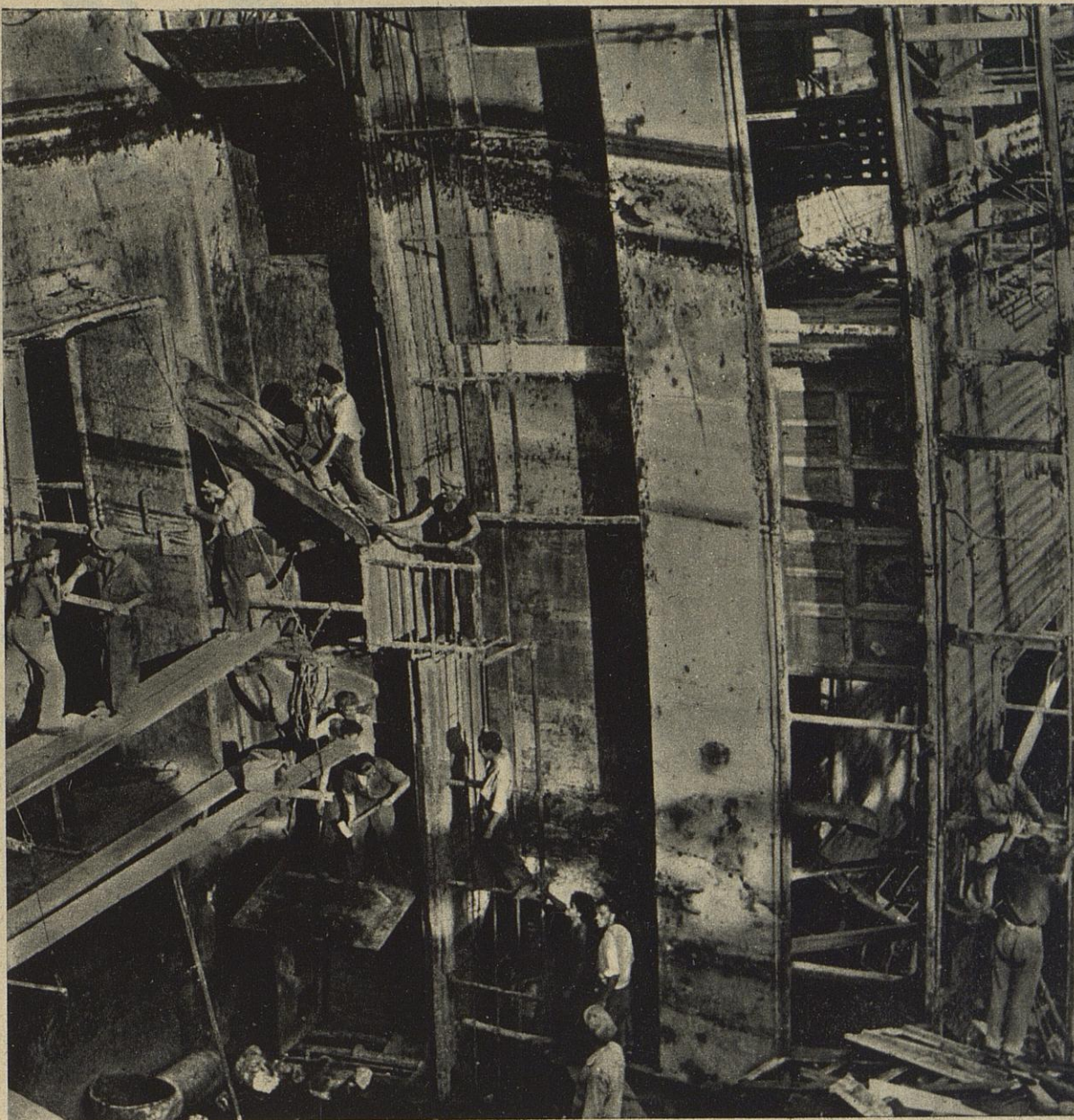
Au radoub, un bateau est couché sur son flanc. Des ouvriers récupèrent le bon matériel avant de le faire sauter.
