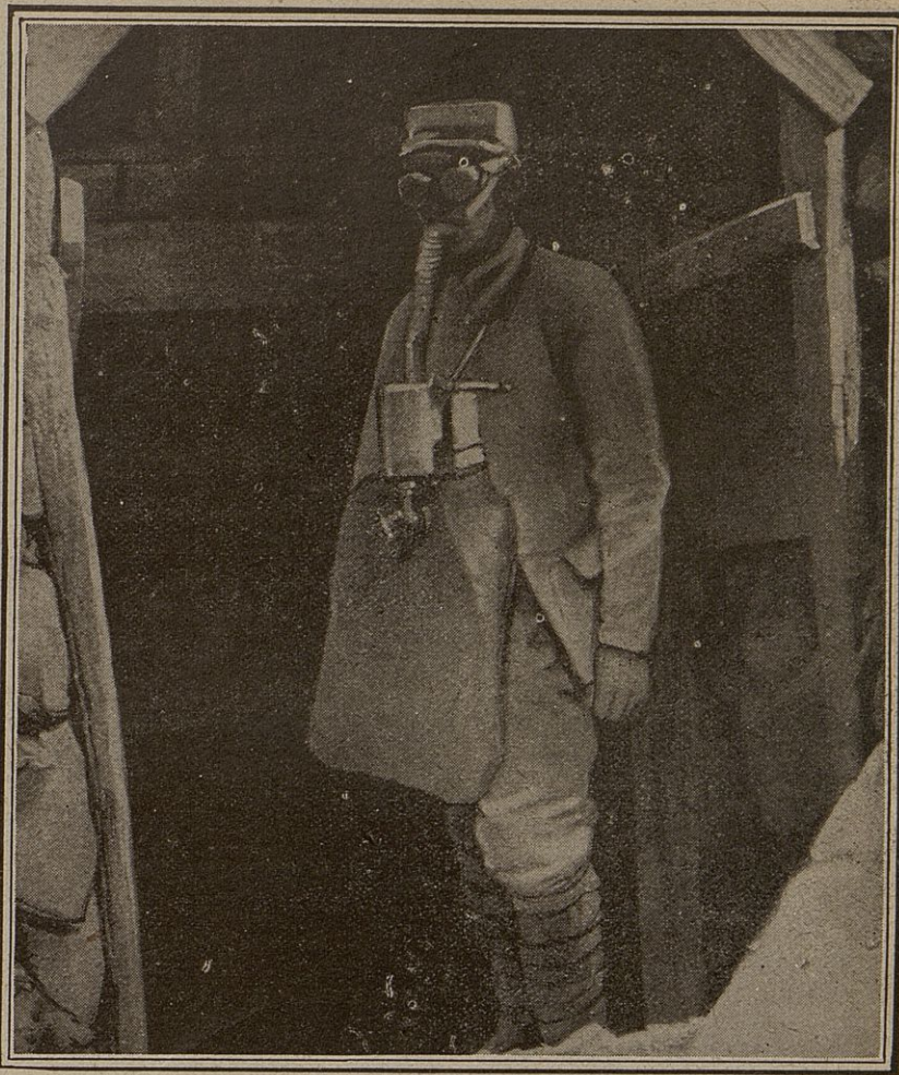
Voici un sapeur muni de l'appareil respiratoire qui lui permet de pénétrer dans les sapes encore remplies des gaz méphitiques produits par les explosions. Il remonte d'une galerie après l'explosion d'une de nos mines.
