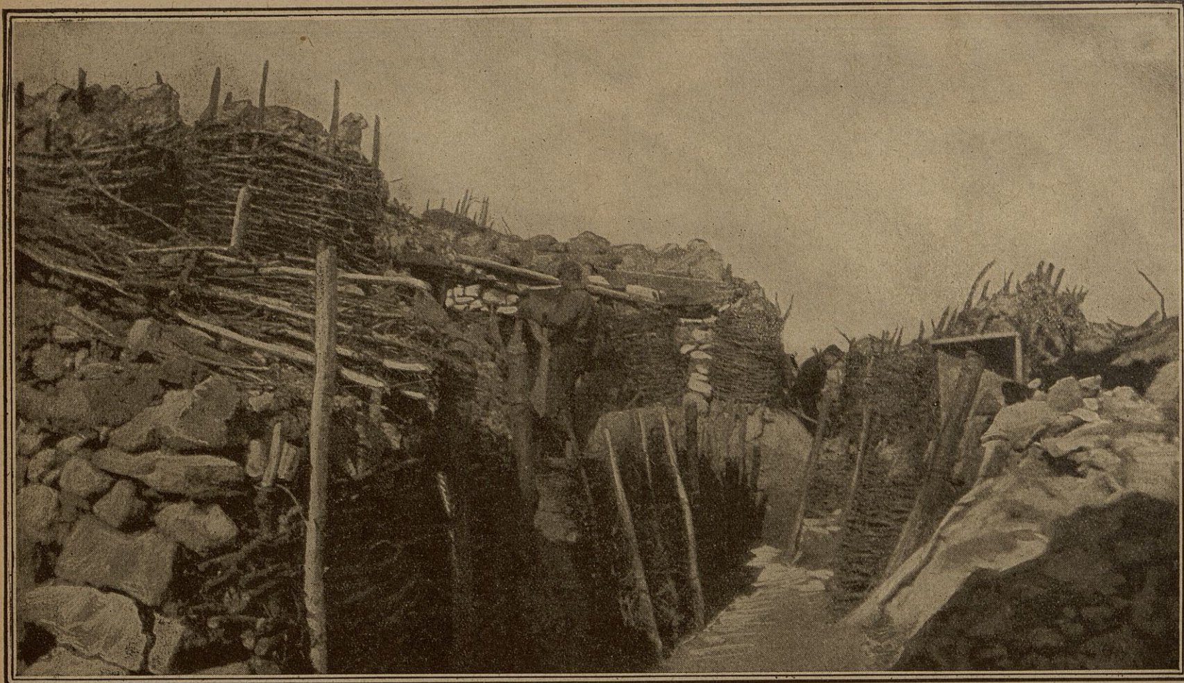
Cette tranchée de première ligne a été photographiée près de Vauquois quelques instants avant un bombardement ; on voit avec quel soin elle avait été aménagée ; un clayonnage serré tenait les terres ; les parapets avaient été renforcés par des gabions solides entre lesquels des créneaux étaient disposés pour la surveillance et le tir.
