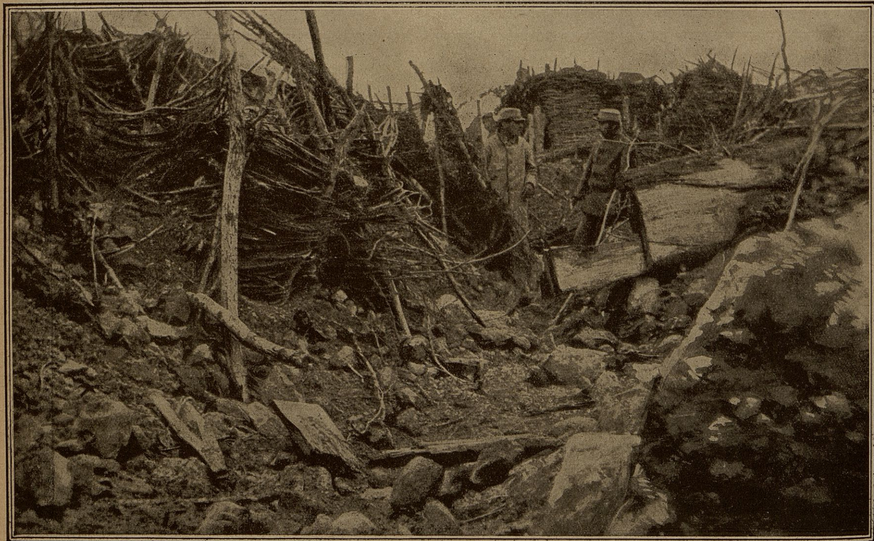
Les Allemands ont bombardé pendant trois heures et voici l'œuvre des bombes et des torpilles aériennes ; tout est bouleversé dans la tranchée ; les gabions sont éventrés, les claies brisées ; heureusement nos poilus s'étaient garés de la trombe de fer dans les abris souterrains ; comme aucune attaque d'infanterie n'a suivi, on en sera quitte pour recommencer l'installation de la tranchée.
