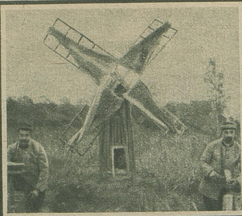
Pour moulin le café qui fera le jus de toute la compagnie, il faut un rude moulin. Aussi le cuisinier d'un parc d'artillerie a-t-il mis à profit un ruisseau pour installer un moulin à eau, tandis qu'un meunier, cuisinier au 7 e d'artillerie à pied, innovait un moulin à vent susceptible de piler également le sel.
