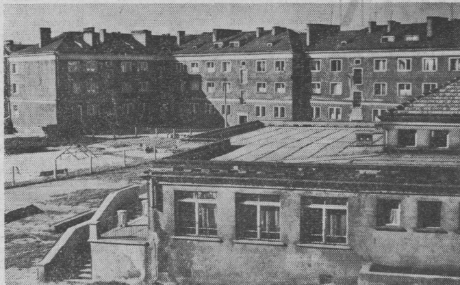
Nowe wygodne bloki mieszkalne osiedla Radzionków III
