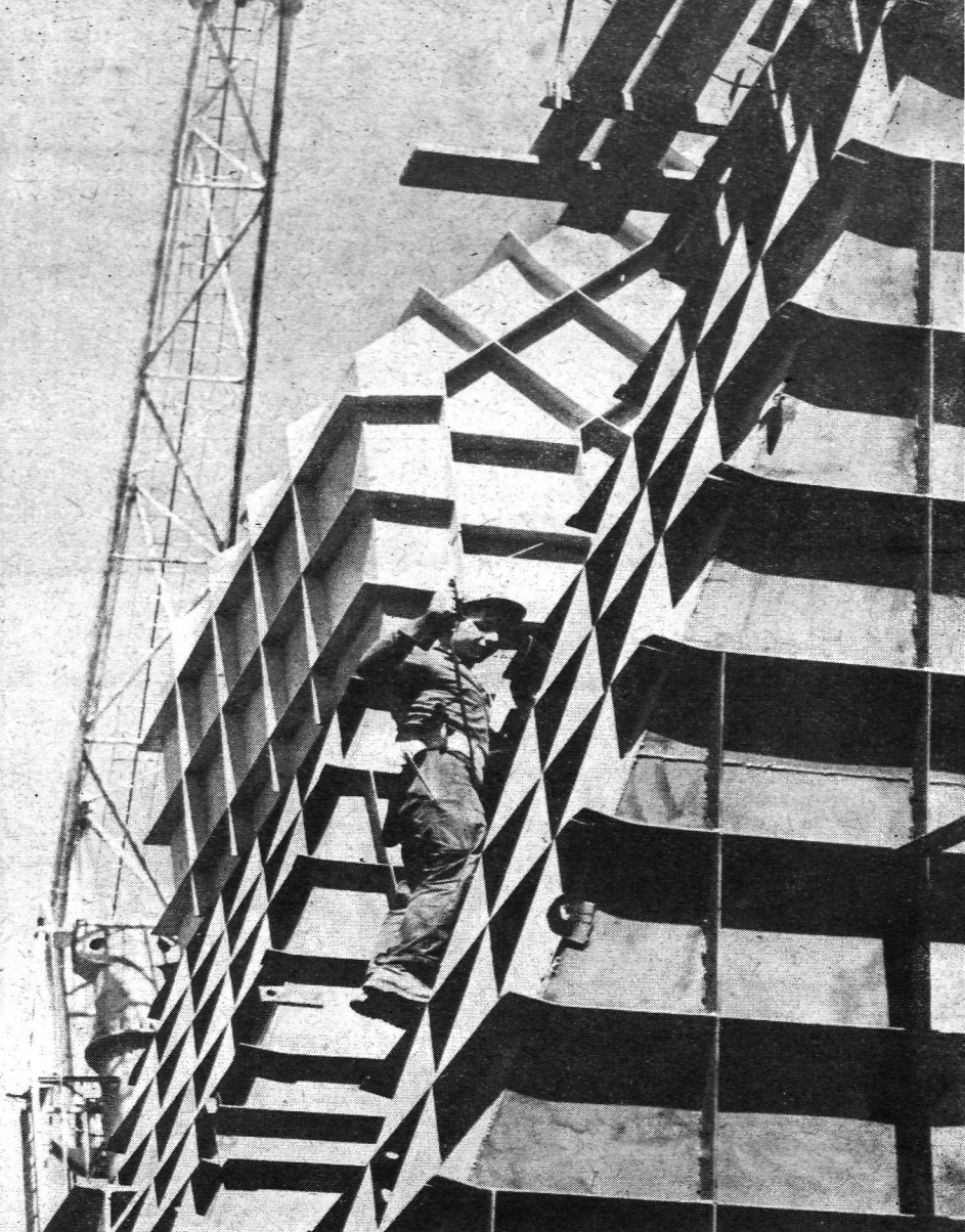
Spawanie ciągów wentylacyjnych. Na rusztowaniu — Andrzej Komorkiewicz
