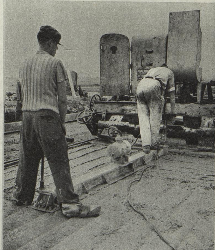
A L'AIDE D'UNE MACHINE SPECIALE, LE CIMENT EST TASSE ET COMPRESSE.
