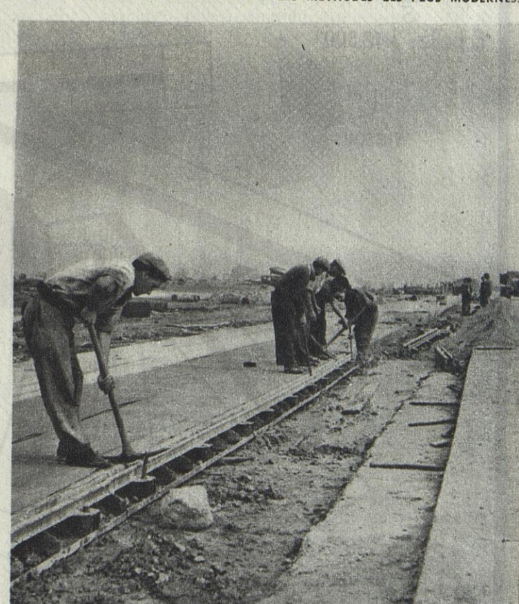
LA RUGOSITE EST ATTENUÉE PAR DE LONGS TAPIS DE LIEGE ET CAOUTCHOUC.
