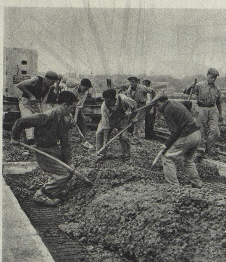
SUR CE GRILLAGE, L'ON COULE DU BETON ARME QUE L'ON COMPRESSERA.
