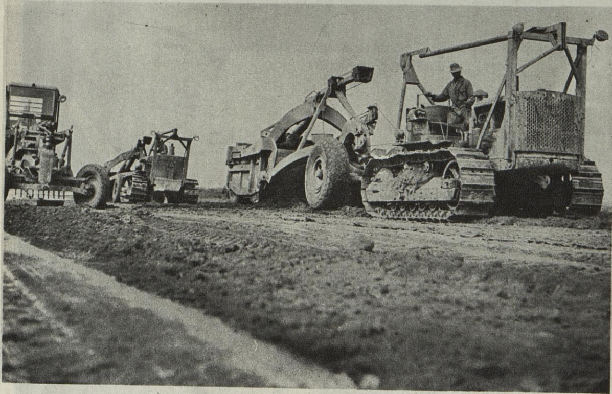
DE LOURDES MACHINES ONT ETE AMENEES POUR APLANIR LE TERRAIN SUR LEQUEL ON CONSTRUIRA LES PISTES D'ATERRISSAGE.
