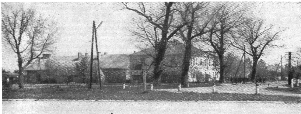
Po koszarach nie zostało śladu. To na tym placu dawniej stał budynek koszar, w którym stacjonował IV pułk Dońskich Kozaków im. grafa Platowa
