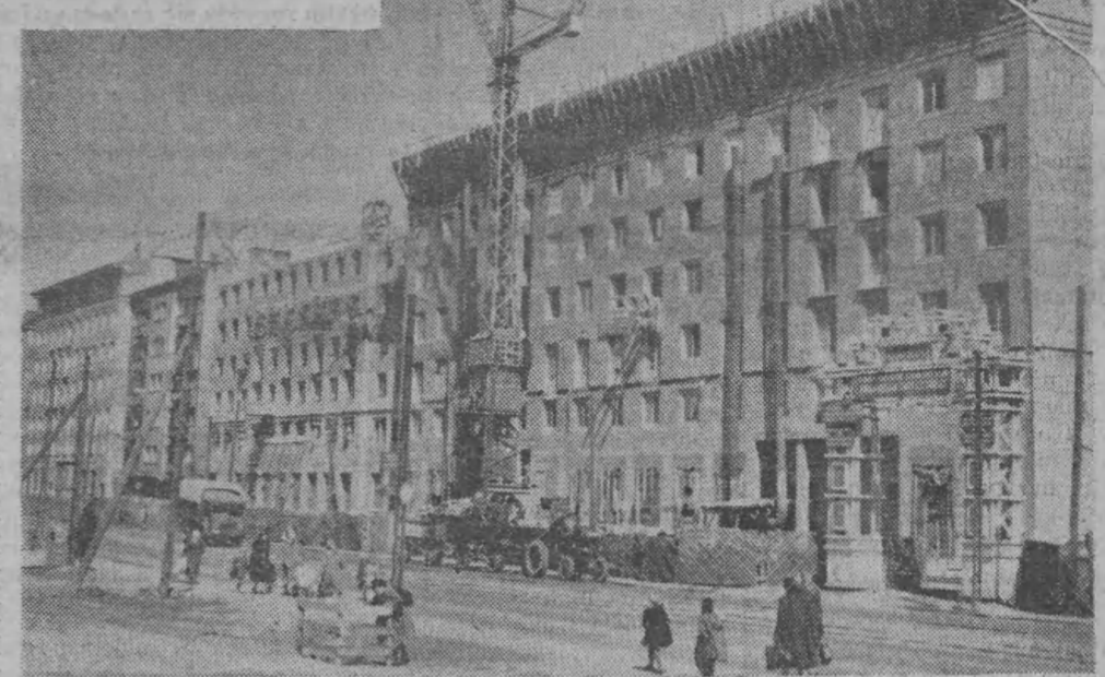
Budowa nowych bloków mieszkaniowych przy ul. Grójeckiej.
