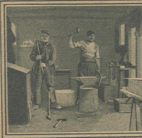
Le wagon-forge. — C'est là que se pratiquent la soudure autogène, le brasage, le redressage, etc.
