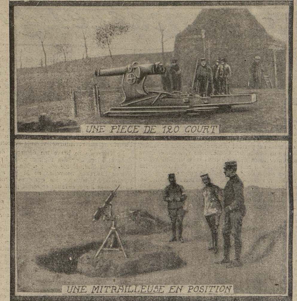
Pour donner la chasse au Taube qui se hasarde au-dessus de nos lignes, une mitrailleuse a été montée sur un solide trépied qui permet au servant de prendre le plus grand angle de tir. Derrière un abri, un 120 court attend qu'on vienne le décapuchonner pour cracher sa mitraille.
