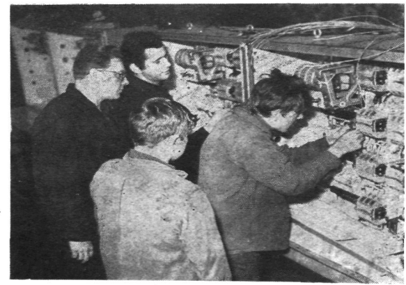
Warsztaty wydziału elektrycznego. Montaż urządzeń tzw. szafy sterowniczej do eksportowanych żurawi budowlanych
