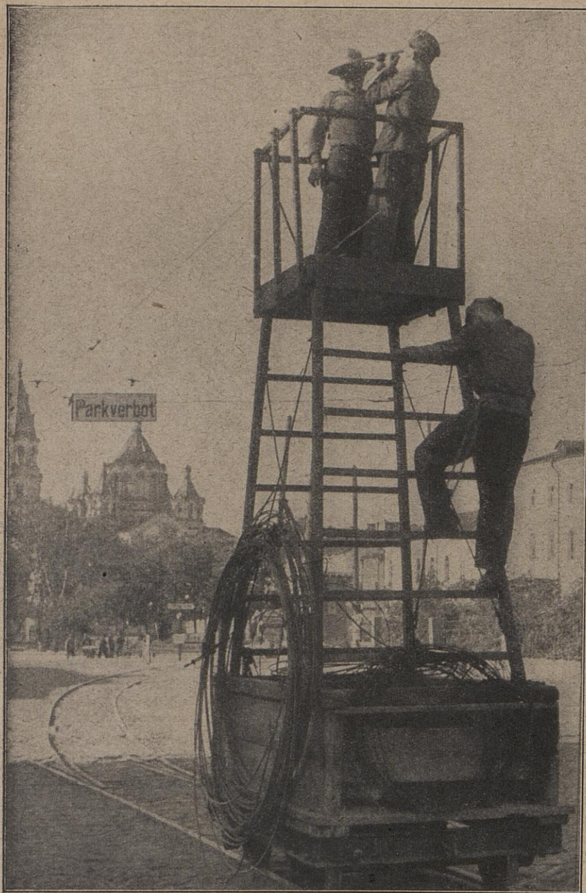
Die Spuren des Krieges, der über die Stadt hinwegbrauste, werden beseitigt: Kurze Zeit nach dem Einrücken der deutschen Truppen durchfahren Arbeiter der Straßenbahnverwaltung die Hauptstraße der ukrainischen Stadt, um die Oberleitung zu reparieren. Das Elektrizitätswerk wurde besetzt, ehe die Bolschewiken es zerstören konnten.
