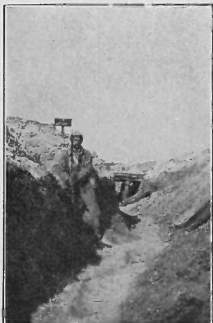
Boyau de Juvincourt (Tranchée boche conquise).
