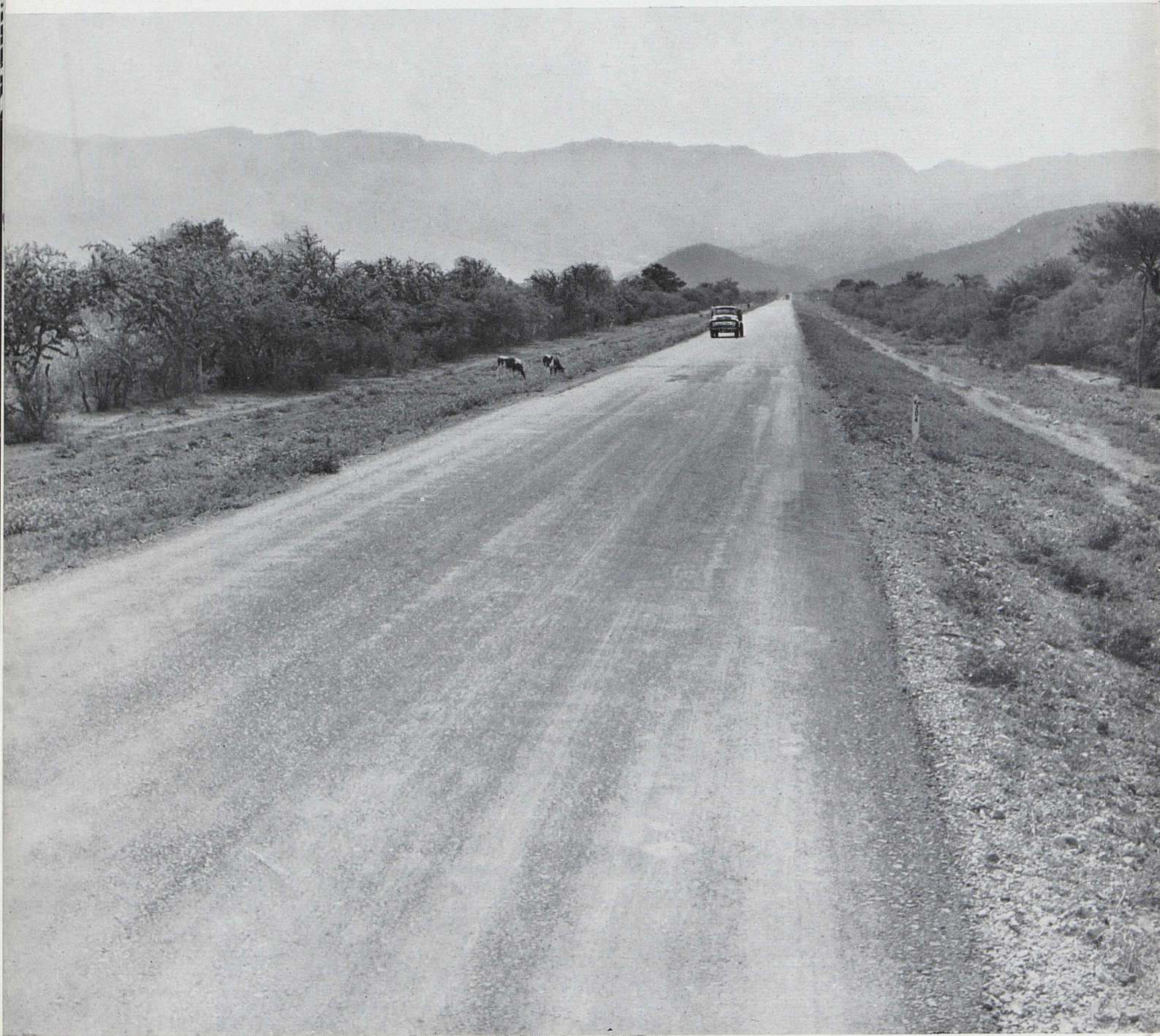
Une nouvelle route.
