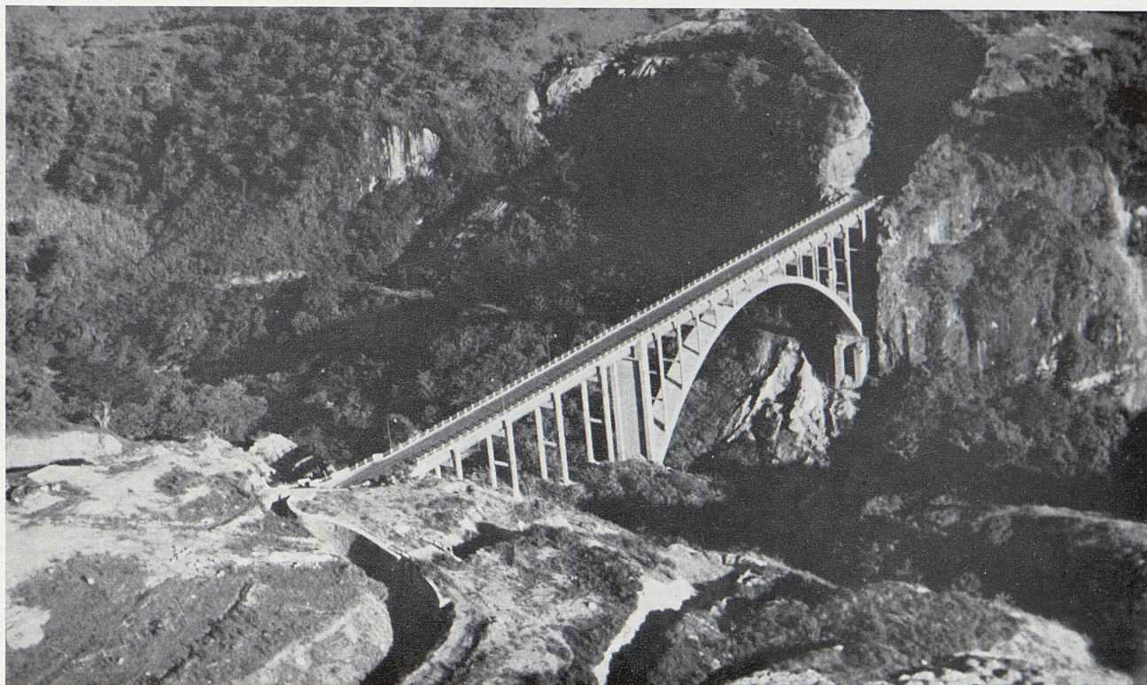
Pont-siphon de Barranca Honda (libère les eaux du Río Cupatitzio à la cadence de 17 mètres cubes à la seconde).
