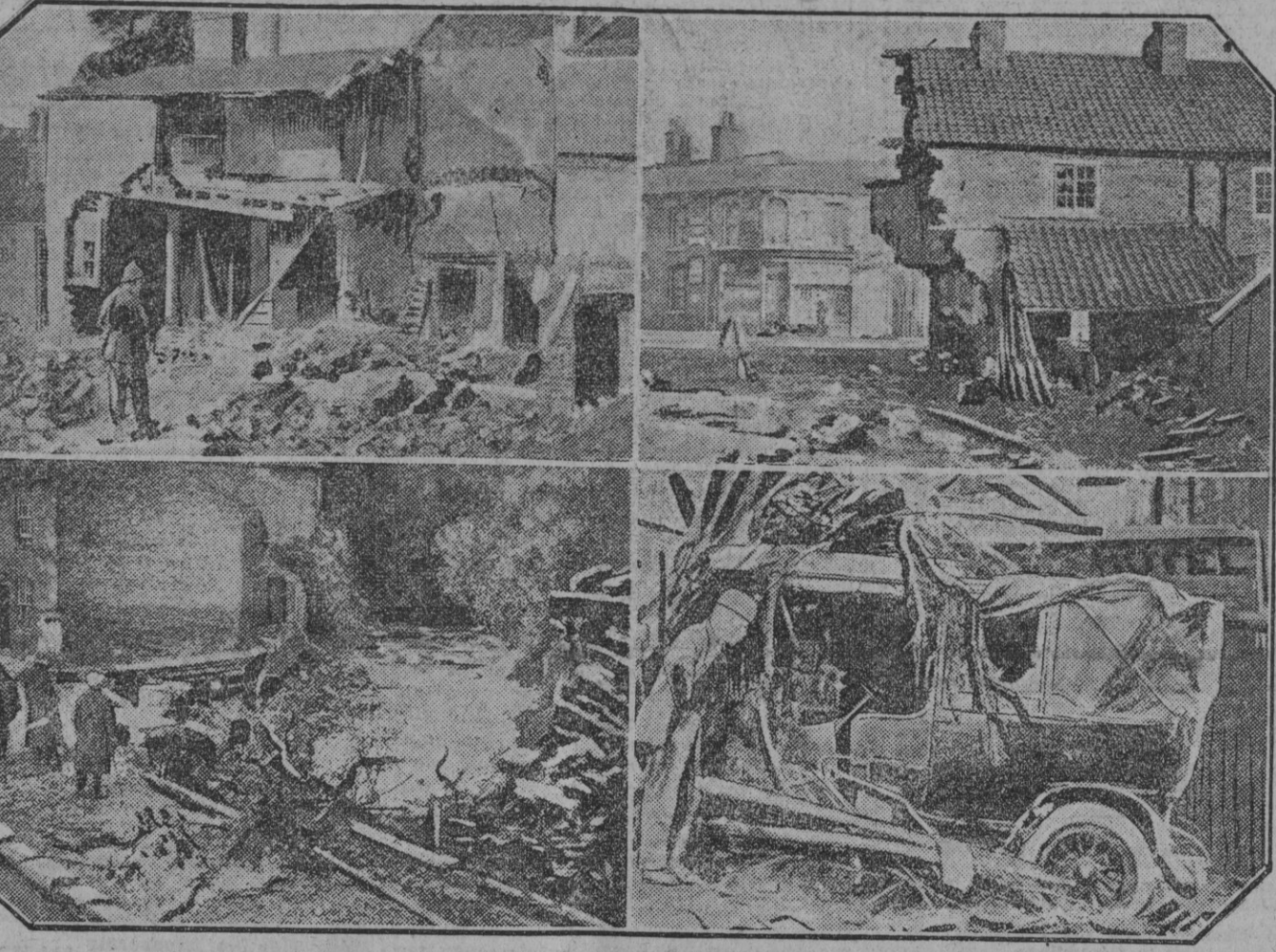
EN HAUT. — A GAUCHE, ce qui reste d'une maison dont les trois habitants ont été noyés. — A DROITE, au cœur de la ville, la brèche faite par le torrent qui a emporté trois maisons lui brisant la route. EN BAS. — A GAUCHE, les débris d'un pont après le passage du torrent. — A DROITE, les restes d'une automobile.
