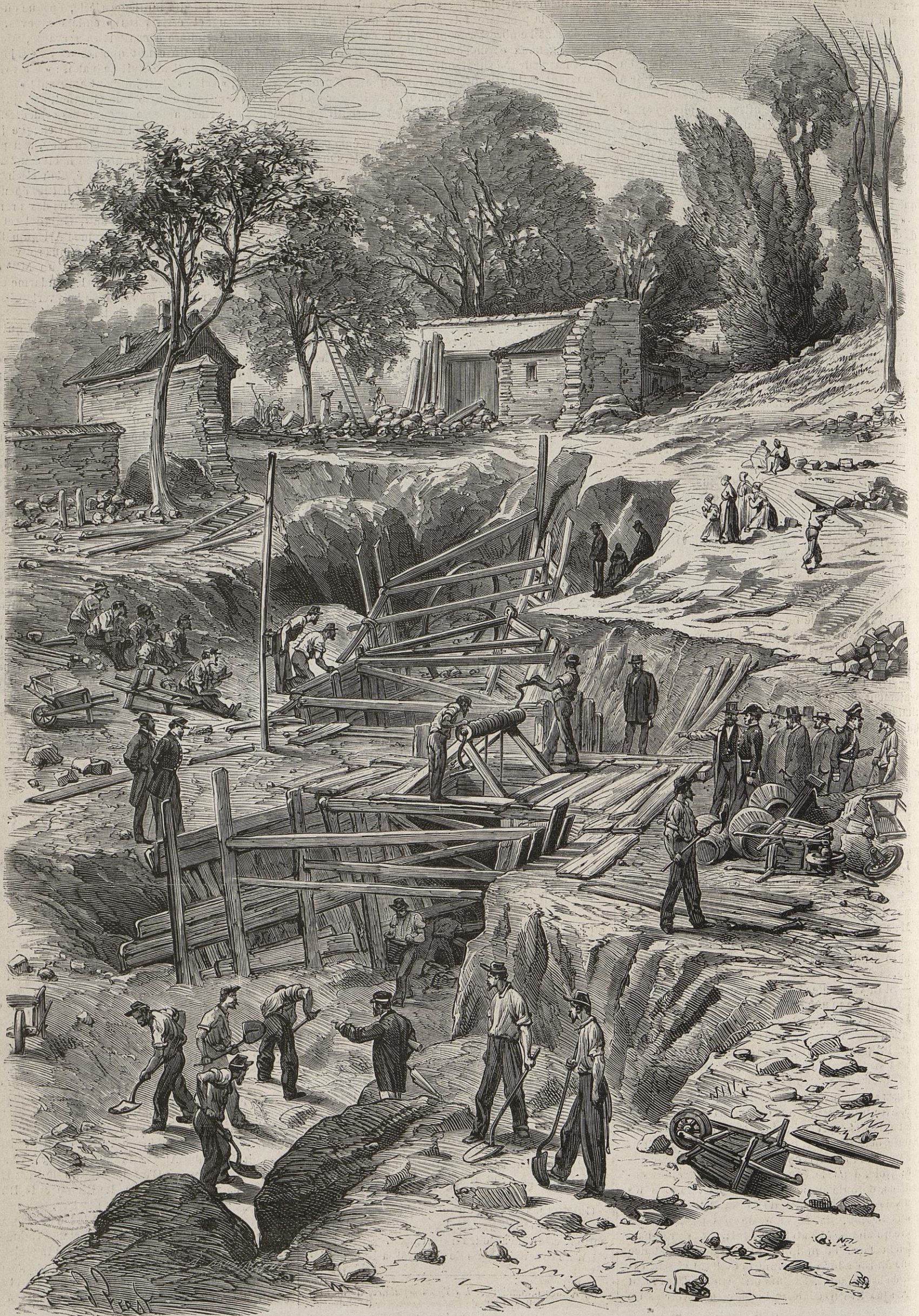
LE PUISATIER DE MONTIGNY-SUR-LOING. — Tranchée ouverte pour porter secours à la victime. (Dessin de M. Féral, d'après le croquis de M. G. de Hagemann.)
