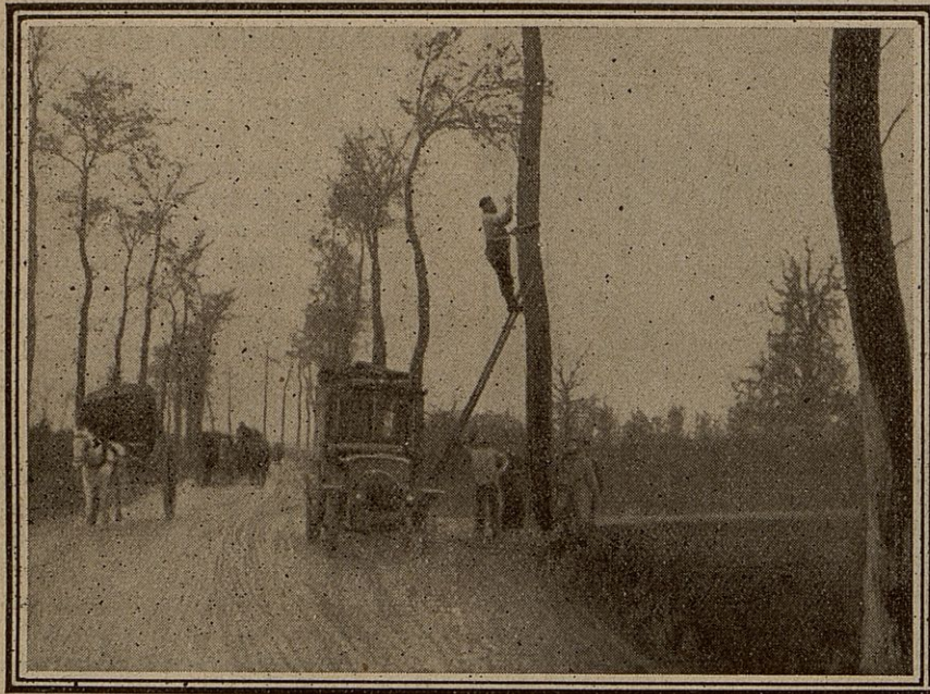
Le long de cette route, aux environs de Dixmude, on procède à l'installation de la ligne téléphonique qui reliera les tranchées aux états-majors. Un autobus a servi à transporter le matériel.
