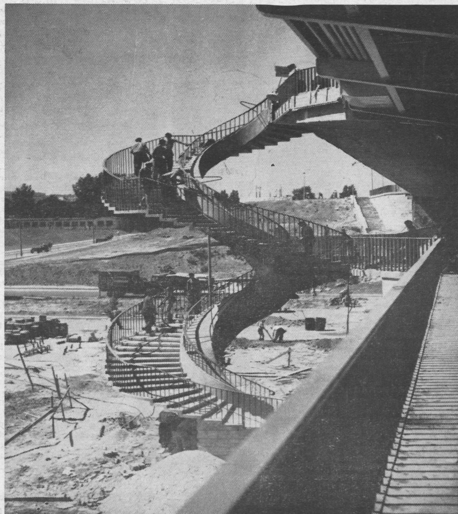
Most Gdański na trasie Starzyńskiego w ostatniej fazie budowy.
