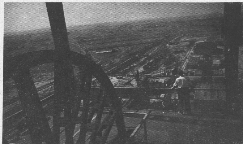
..W Mszanie koło Rybnika trwają prace nad budową nowej kopalni.
