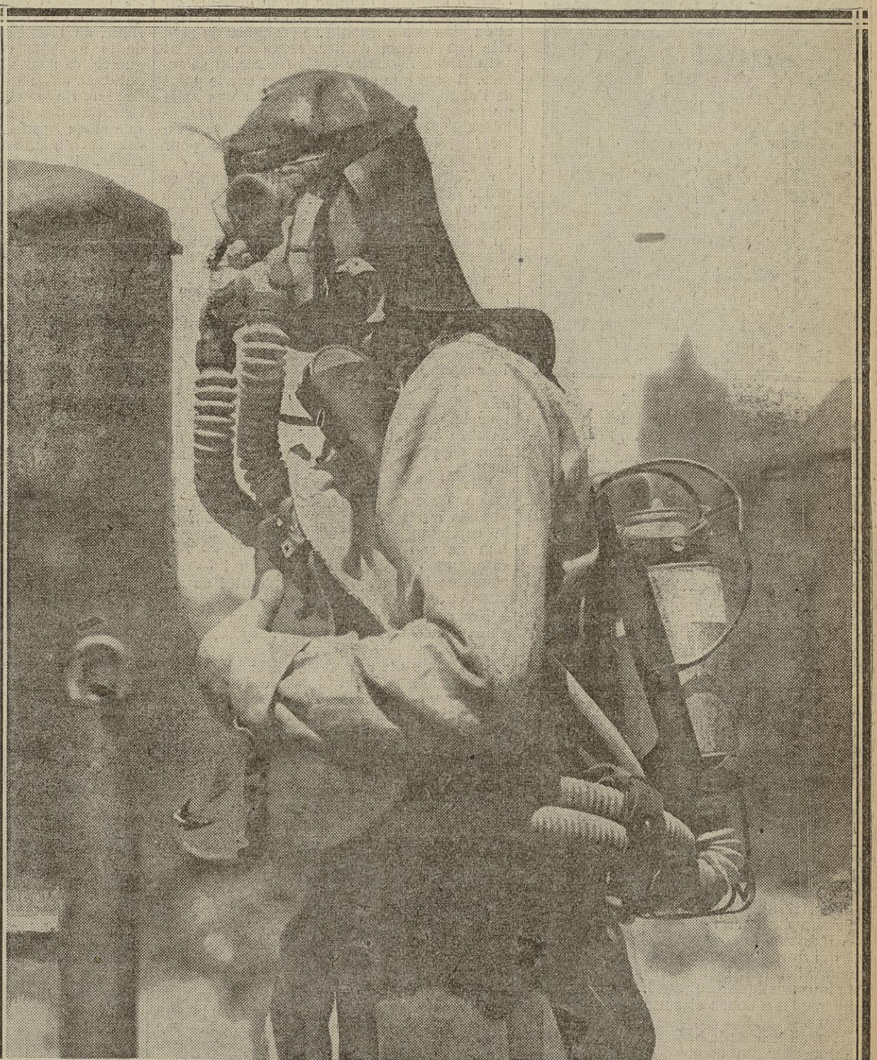
CE MASQUE SEMBLE FORT COMPLIQUÉ; IL EST, DIT-ON, TRÈS EFFICACE Chaque gaz, dans le masque protecteur, exige un "sachet" spécial. Les Américains viennent d'établir, pour leurs soldats, un masque qui prévoit tous les gaz existants.
