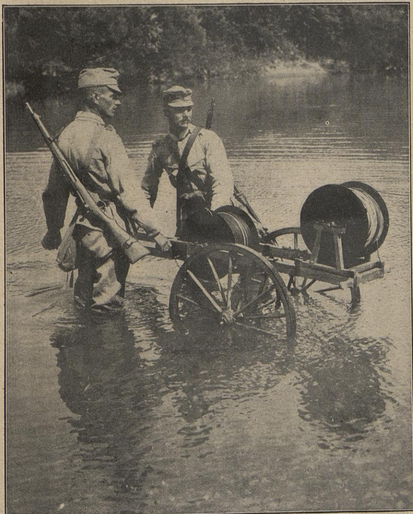
Legen eines Kabels über den Jonzo.
