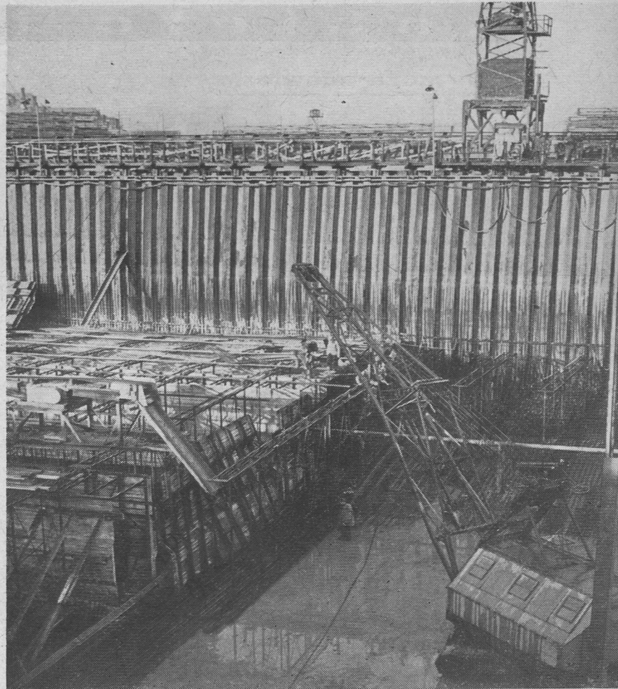
Le coulage du béton avance rapidement et la forme de la future cale sèche commence à apparaître à vue d'oeil
