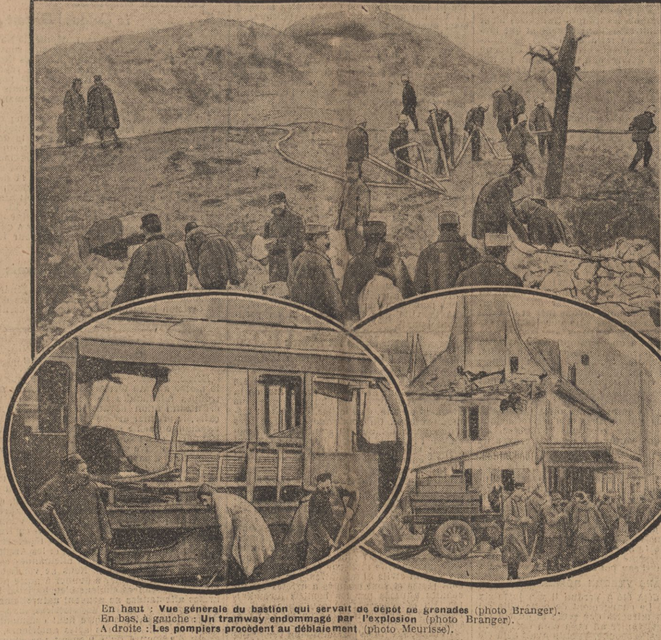
En haut: Vue générale du bassin qui servait de dépôt de grandes (photo Branger). En bas, à gauche: Un tramway endommagé par l'explosion (photo Branger). A droite: Les pompiers procédant au déblaiement (photo Meurisse).
