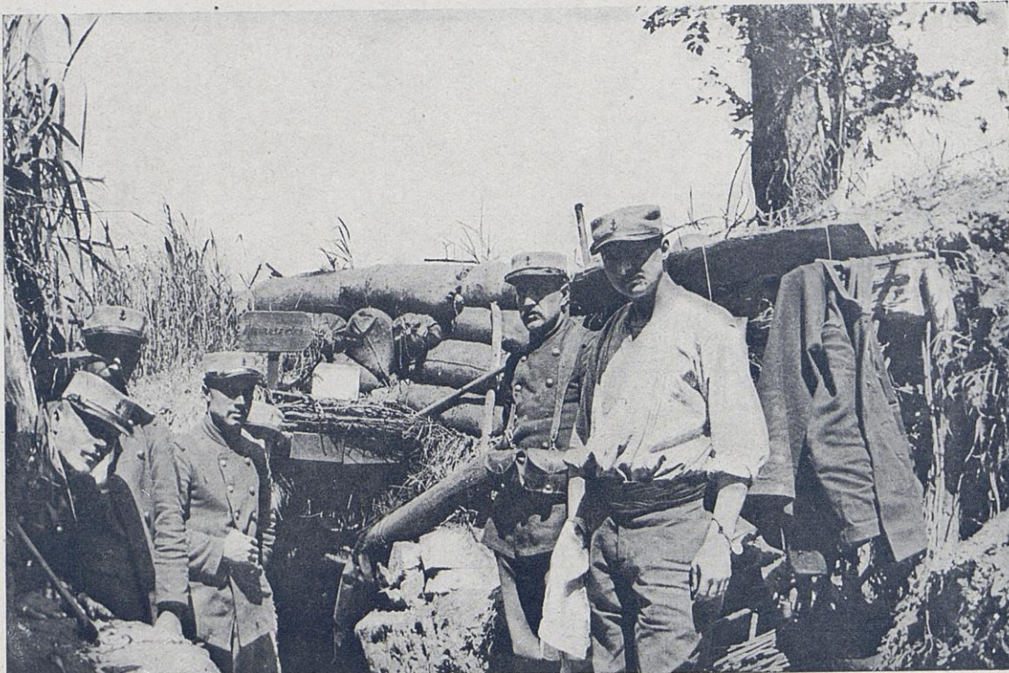
Cagna près de la Sucrierie de Dompierre. Une mitrailleuse située à l'intérieur et bien alimentée suffit à défendre l'accès de tout le vallon.
