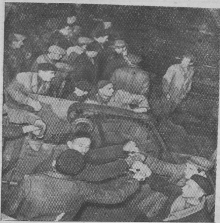
Brygada przy kołowrocie dźwigowym
