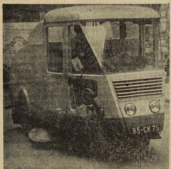
Służba oczyszczania ulic w Paryżu wyposażona została w nowe modele specjalnych wozów t.zw. „ramasse-miettes”. Pojazd te skrapiają ulice i przy pomocy automatycznych szczotek czyszczą je jednocześnie. Oto jeden z tych nowych wozów, których praca przeciętnie zastępuje 10 robotników... (Pot. Universal)
