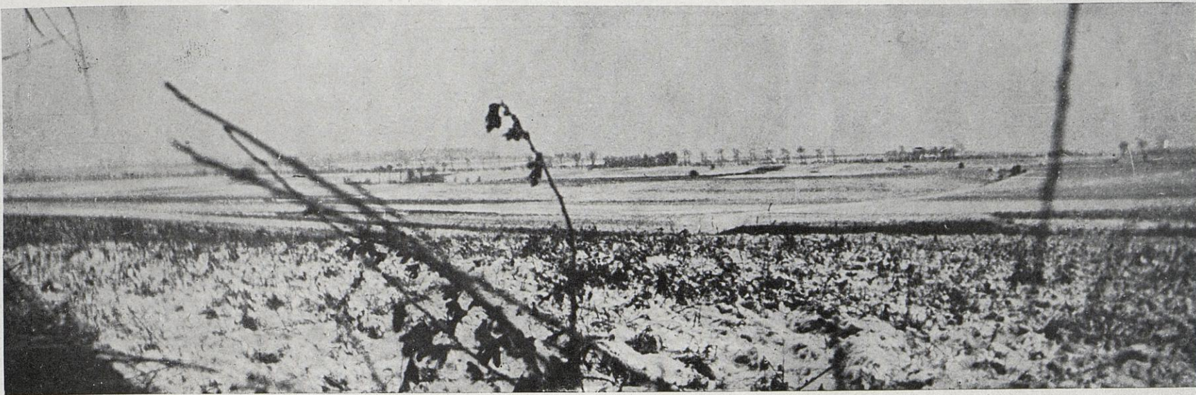
Ce que l'on voit d'une tranchée allemande reprise par les Français.
