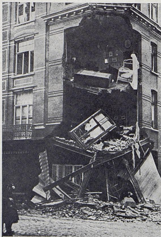
Les effets d'un obus de 420 sur une maison à Anvers.
