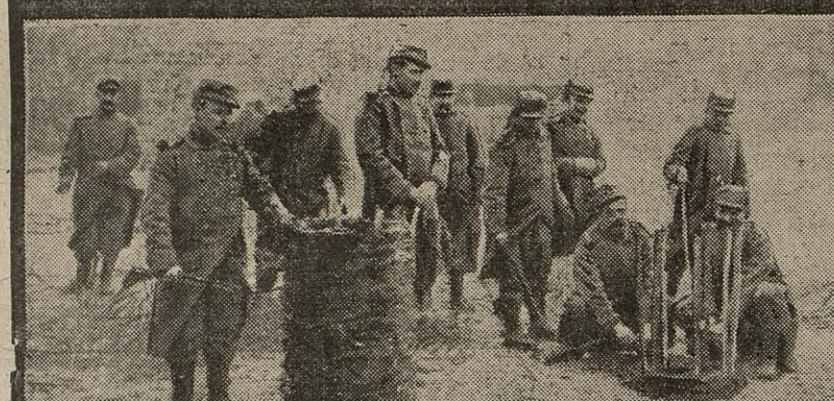
A DROITE : LE TRESSAGE D'UN GABION A GAUCHE : UN GABION TERMINE
