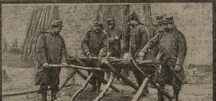
LA CONSTRUCTION D'UNE FASCINE
