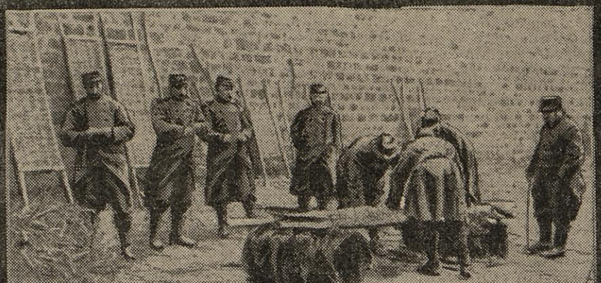
ON ACCOUPLE DEUX GABIONS
