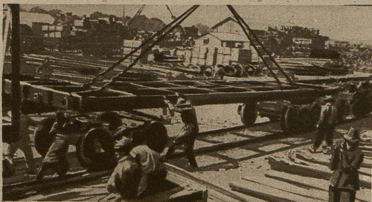
MONTAGE DES CHASSIS DE WAGONS.
