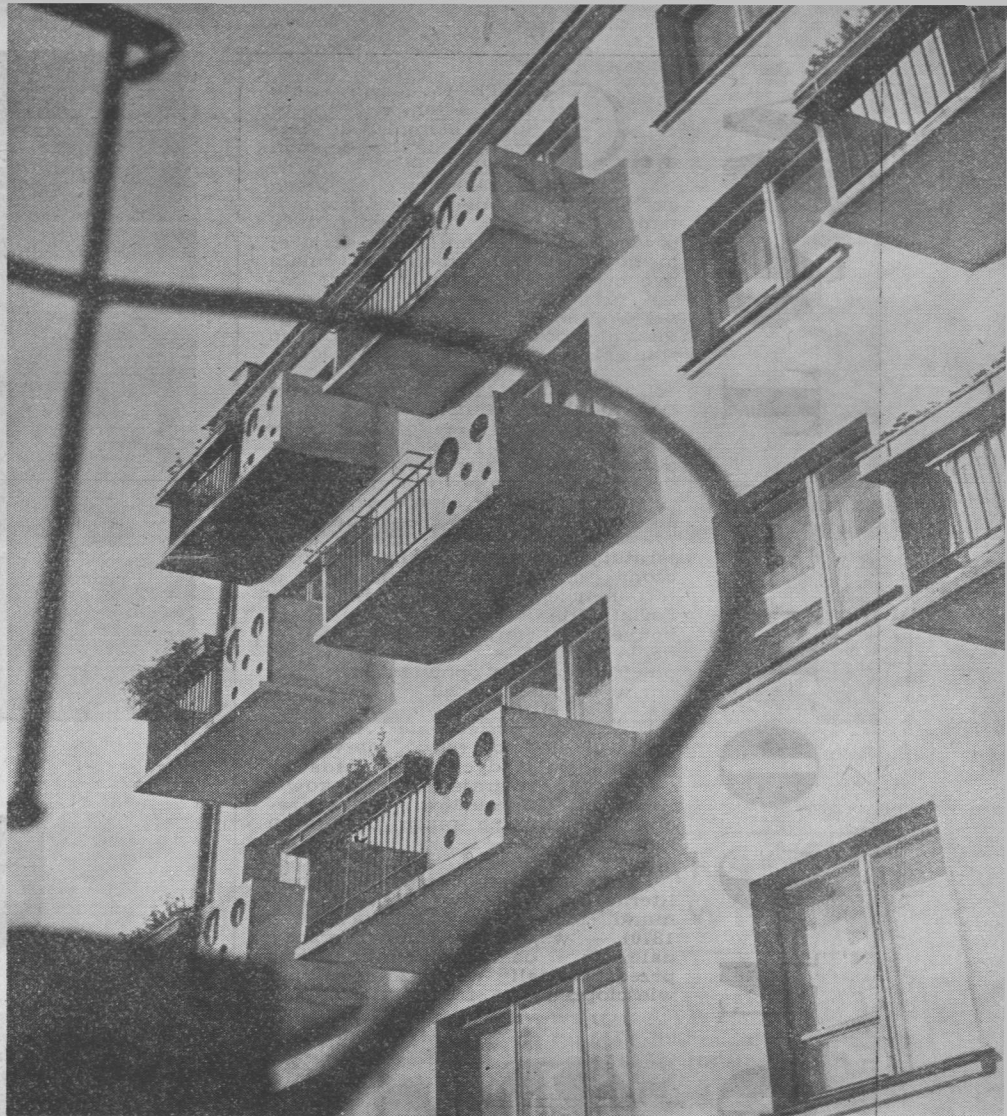
Nowo budowane domy są bardzo różnorodne i nowoczesne. Te, które widzimy na zdjęciu, wzniesiono w ubiegłym roku. Łomża ma wprawdzie połączenie kolejowe z miastem wojewódzkim — Białymstokiem (103 km) i z sąsiednią Ostrołęką (43 km), z włókienniczym Zambrowem, ale autobusy mają większe powodzenie (z Warszawy dojechać można w niecałe 3 godziny — 140 km). Zdjęcie poniżej przedstawia zawsze gwarny Rynek Zambrowski w Łomży
